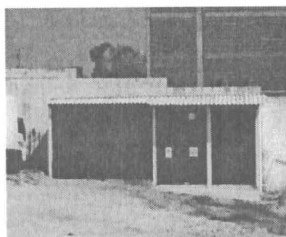
Foto 7. Nueva área de almacenamiento de residuos ordinarios y peligrosos.
